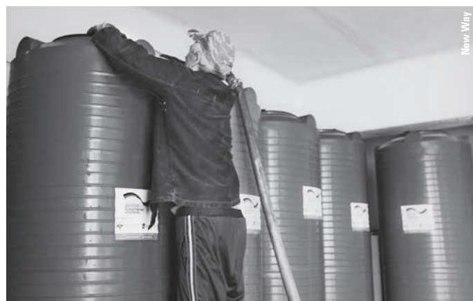
Mit unserer Unterstützung installiert ein Projektpartner im Dorf Wassertanks und sorgt für die regelmäßige Lieferung von sauberem Wasser.
